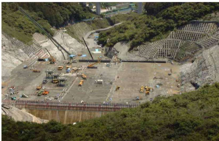
面状工法による打設面の全景
