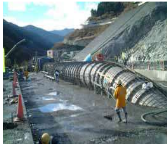
Embedding an outlet conduit
